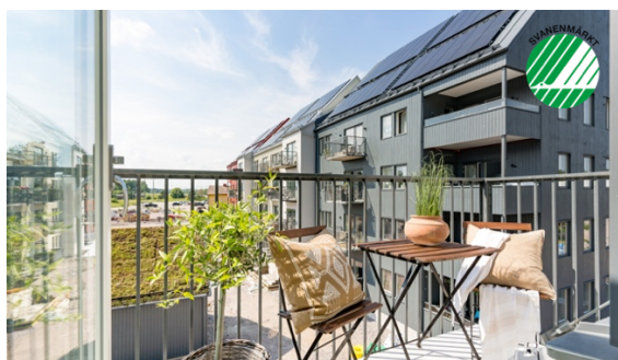
Exempel på gröna byggnader – Gävle Kungsbäck 2:29
