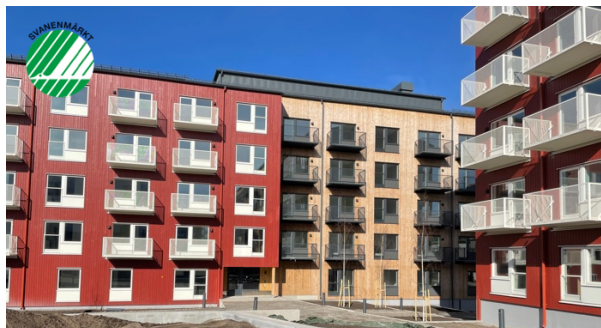
Exempel på gröna byggnader – Sundsvall Förrådet 4
