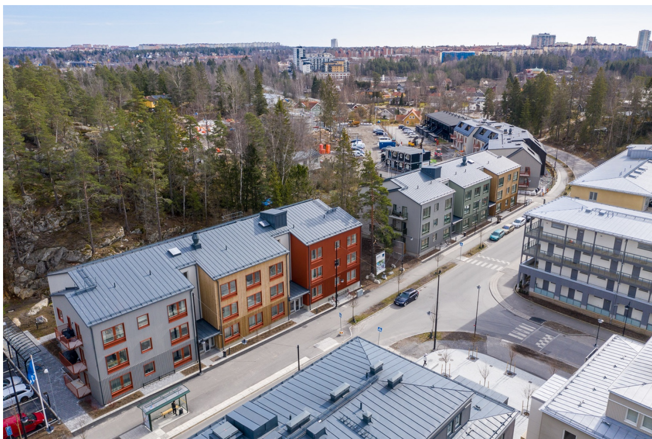
Foto av den sista etappen av K2A:s projekt i Vega Park i Haninge. I den sista etappen färdigställs 154 hyresbostäder och totalt förvaltar K2A numera 462 yteffektiva hyresbostäder i Vega Park. Samtliga bostäder är byggda i trä. Under 2019 invigdes den nya pendeltågsstationen som ligger omkring 800 meter från K2A förvaltningsobjekt.
