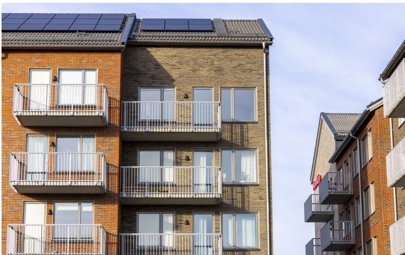
Under perioden färdigställdes den sista etappen i ett nyproduktionsprojekt i Örby i södra Stockholm. Den sista etappen i ett uppgraderingsprojekt av befintliga lägenheter i samma område pågår.
