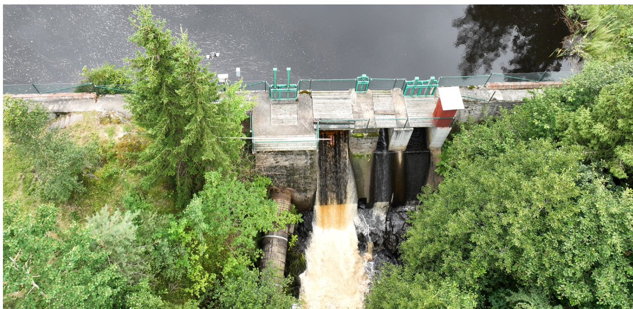
Hulebodammen, Hulebo kraftverk i Bankeryd.
