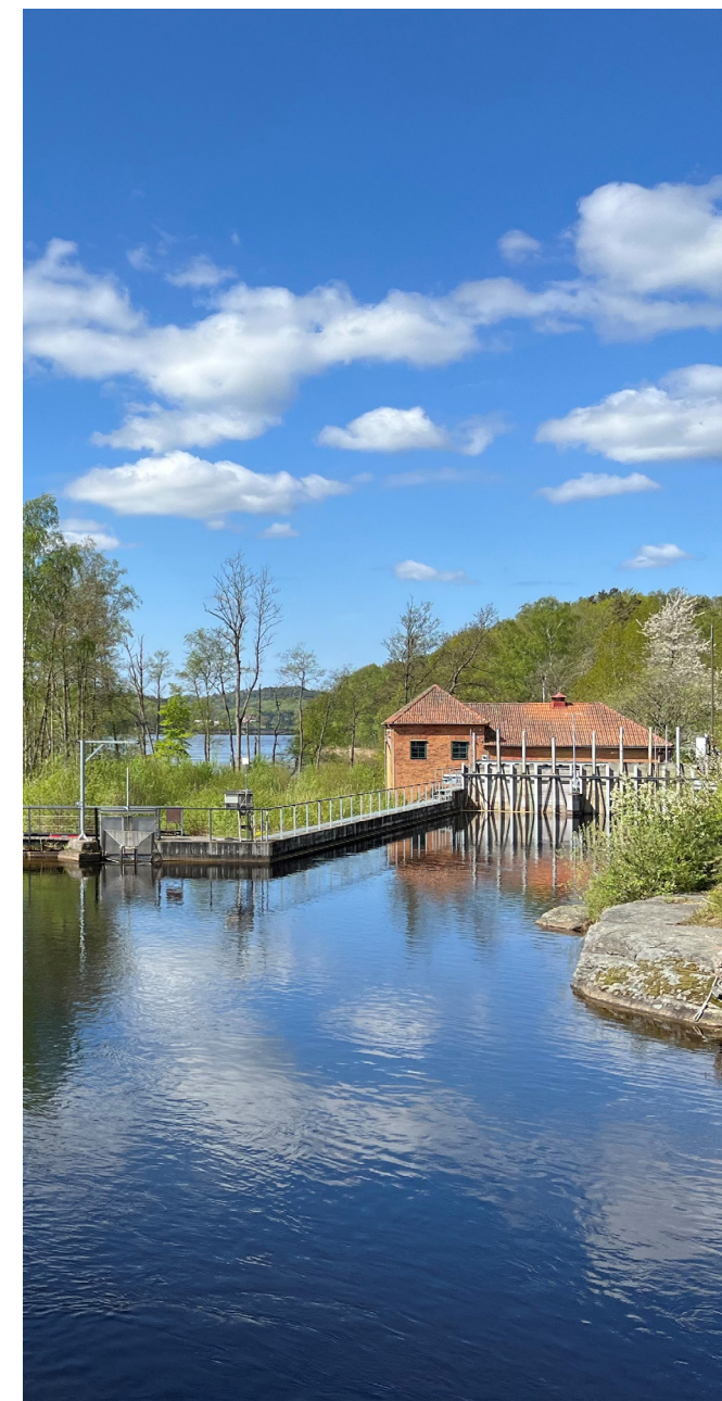
Ålgårda kraftverk i Kungsbacka
