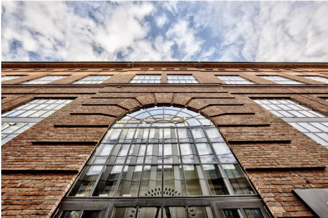
Verkstedhallene, Aker Brygge - Oslo
