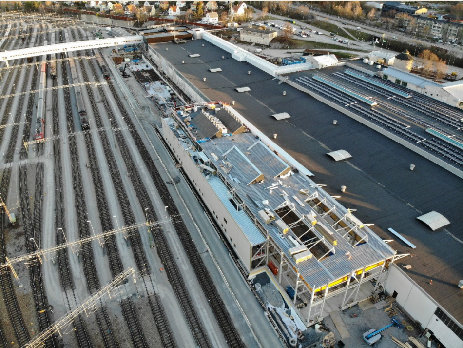
Hagalunds Depå, Västra Vagnhallen. Här uppför Jernhusen utökad depåkapacitet för SJ:s nya flotta av regionaltåg.
