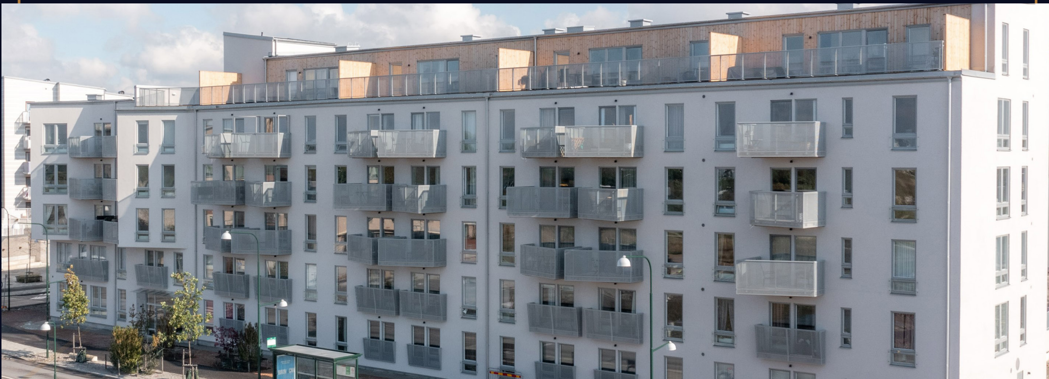
Kvarteret Höfånget 1 i Malmö, ett lamellhus med 97 lägenheter.
