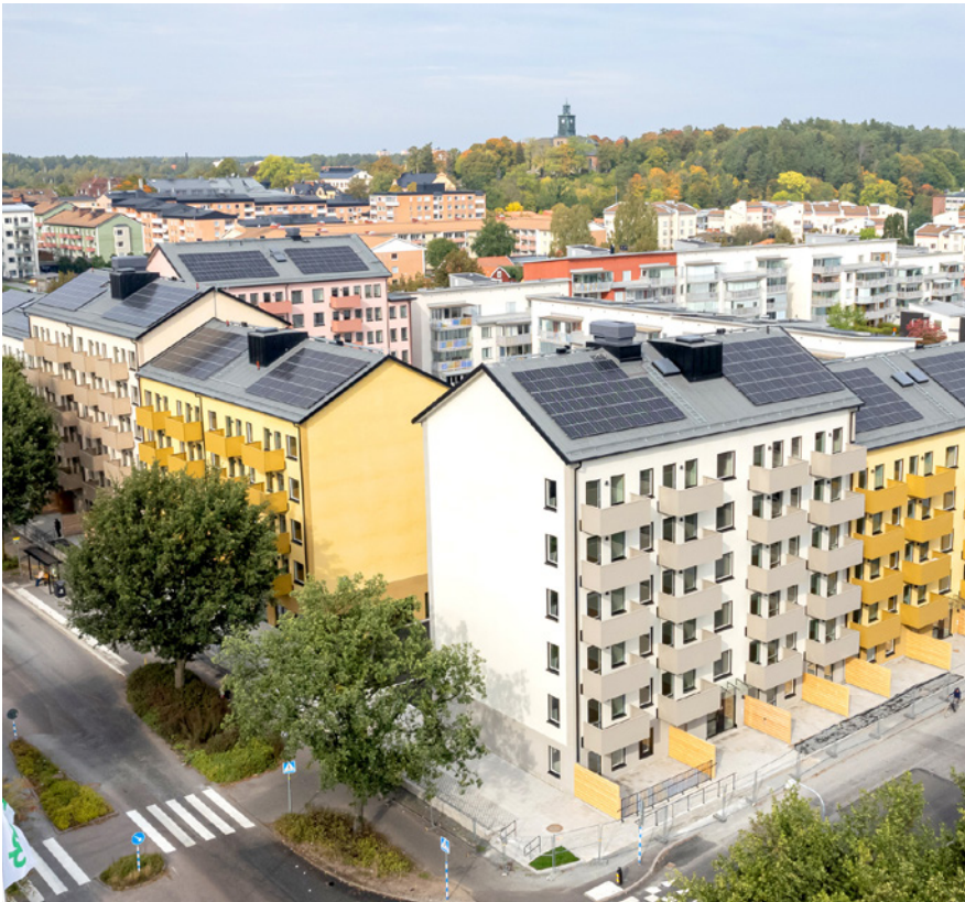
Projekt Korsängen med bostäder i centrala Enköping färdigställdes under det fjärde kvartalet 2024.
