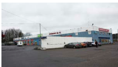
Fastighetsbeteckning: Backa 31:1, 31:2 & 766:723 Region: Göteborg Uthyrningsbar yta: 2 360 kvm
