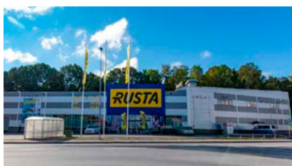
Fastighetsbeteckning: Kumlaknekten 2 Region: Stockholm Uthyrningsbar yta: 2 372 kvm
