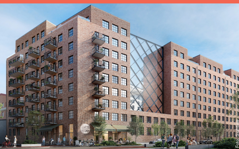
I Gamlestadens Fabriker tillträdde JM den förvärvade bostadsbyggrätten Olskroken 18:8 under tredje kvartalet där byggnation av 330 bostäder har påbörjats.
