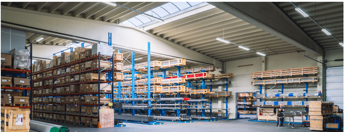
Under det första kvartalet har Sagax förvärvat fastigheten Keurweg 2 i Waalwijk, öster om Rotterdam. Fastigheten består av kontors-, lager- och produktionslokaler omfattande 2 700 kvadratmeter uthyrningsbar area.
