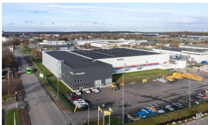
Fastigheten Grusbädden 1 i Helsingborg.
