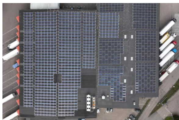
Fastigheten Kolven 4 i Helsingborg.
