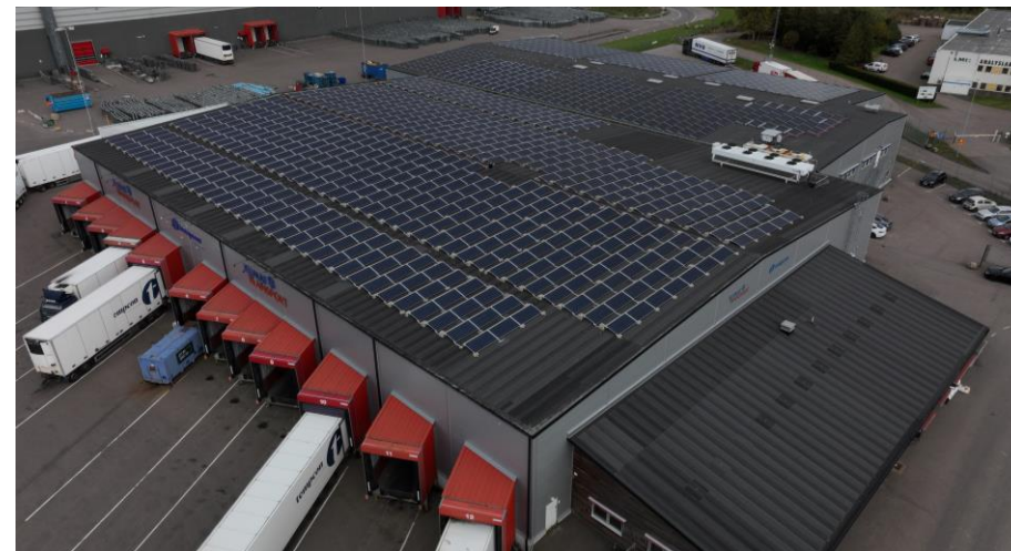
Fastigheten Kolven 4 i Helsingborg.
