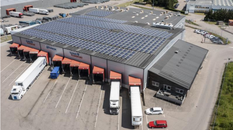
Fastigheten Kolven 4 i Helsingborg.
