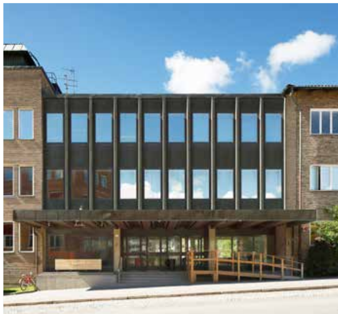
EKEN 14 – I slutet av maj förvärvade vi kontorsfastigheten Eken 14 i centrala Sundbyberg. Fastigheten ligger i direkt anslutning till den välkända Marabouparken och Chokladfabriken.
