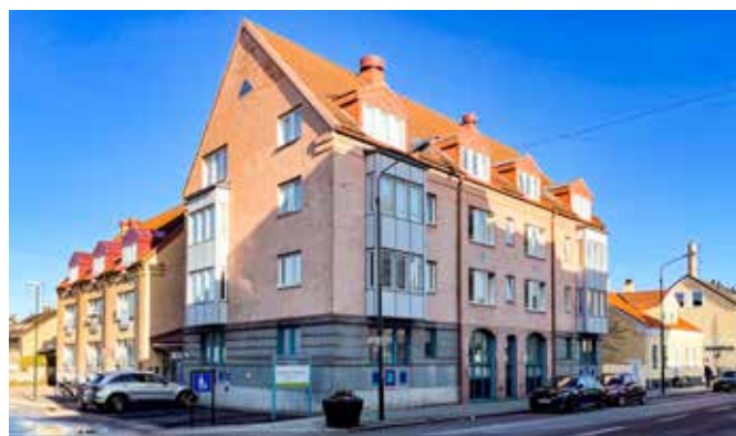
Foto ovan: Nattskärnan 7, Malmö. Efter periodens utgång tecknades avtal om förvärv av en bostadsfastighet i Malmö med 24 lägenheter.
