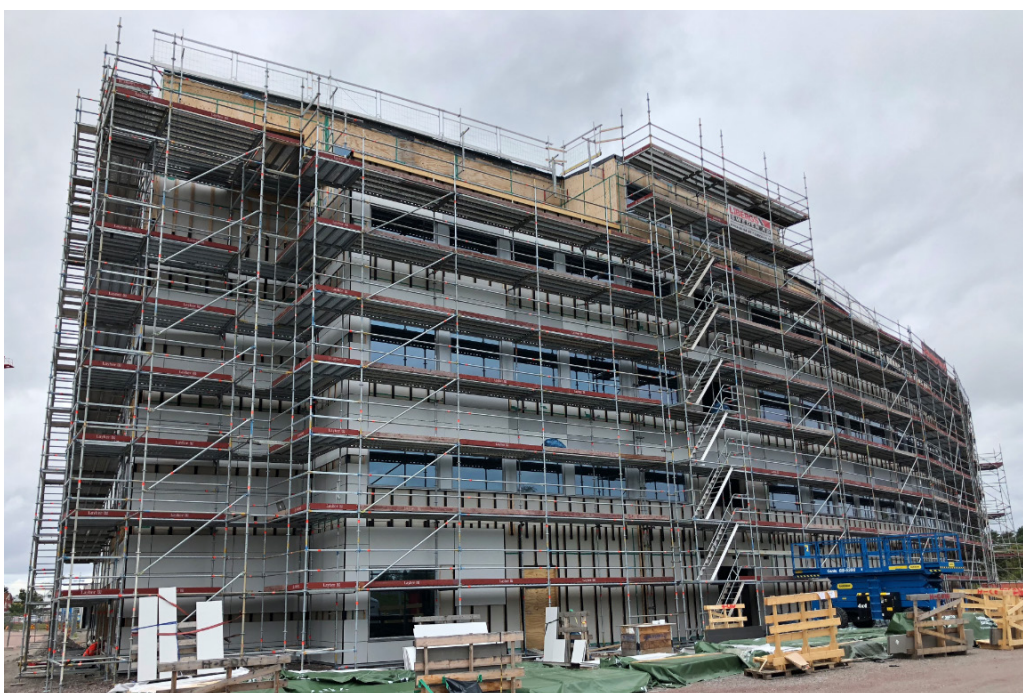
Nybyggnation i Karlstad, Kv. Fanfaren, etapp 2.
