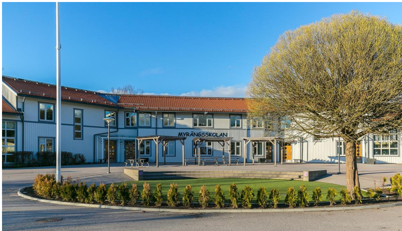
Exteriörbild på skolfastigheten Frostfjärilen 44 i Huddinge, Stockholm
