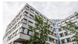
Borgarfjord 5 Stockholm PÅGÅENDE Ombyggnation kontor Investering: 162 mkr
