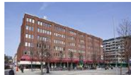
Bollbro 15 Helsingborg PÅGÅENDE Ombyggnation samhällsfast. Investering: 125 mkr
