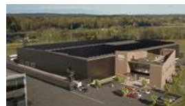
Åseby 1:5 Göteborg PÅGÅENDE Nybyggnation samhällsfast. Investering: 301 mkr
