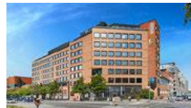
Hornsberg 10 Stockholm PÅGÅENDE Ombyggnation kontor Investering: 238 mkr
