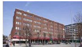
Bollbro 15 Helsingborg PÅGÅENDE Ombyggnation samhällsfast. Investering: 125 mkr
