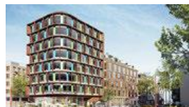
GreenHaus Helsingborg PÅGÅENDE Nybyggnation kontor Investering: 320 mkr
