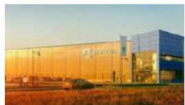
Göttaland 5 Jönköping PÅGÅENDE Ombyggnation kontor Investering: 281 mkr
