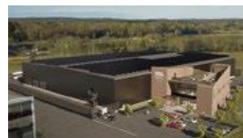
Åseby 1:5 Göteborg PÅGÅENDE Nybyggnation samhällsfast. Investering: 301 mkr
