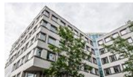
Borgarfjord 5 Stockholm PÅGÅENDE Ombyggnation kontor Investering: 162 mkr
