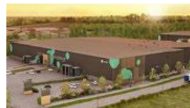
Örnäs 1:17 Stockholm PÅGÅENDE Nybyggnation logistik Investering: 218 mkr
