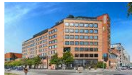
Hornsberg 10 Stockholm PÅGÅENDE Ombyggnation kontor Investering: 238 mkr
