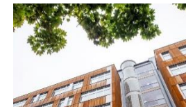
Rotterdam 1 Stockholm FÄRDIGSTÄLLD ELLER HELT/DELVIS INFLYTTAD Ombyggnation kontor Investering: 236 mkr
