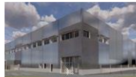
Drevet 1/Långeberga Helsingborg PÅGÅENDE Nybyggnation logistik Investering: 261 mkr
