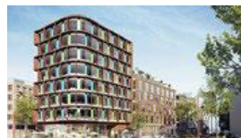
GreenHaus Helsingborg PÅGÅENDE Nybyggnation kontor Investering: 320 mkr
