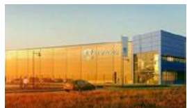
Götaland 5 Jönköping PÅGÅENDE Ombyggnation kontor Investering: 281 mkr
