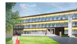
Hissmontören 4 Örebro FÄRDIGSTÄLLD ELLER HELT/DELVIS INFLYTTAD FÄRDIGSTÄLLD Nybyggnation kontor Investering: 118 mkr
