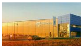
Götaland 5 Jönköping PÅGÅENDE Ombyggnation kontor/ nybyggnation samhällsfast. Investering: 437 mkr
