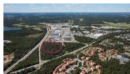
Kungsängen Tibble 1:648 Stockholm PÅGÅENDE Nybyggnation kontor Investering: 301 mkr
