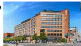
Hornsberg 10 Stockholm PÅGÅENDE Ombyggnation kontor Investering: 238 mkr
