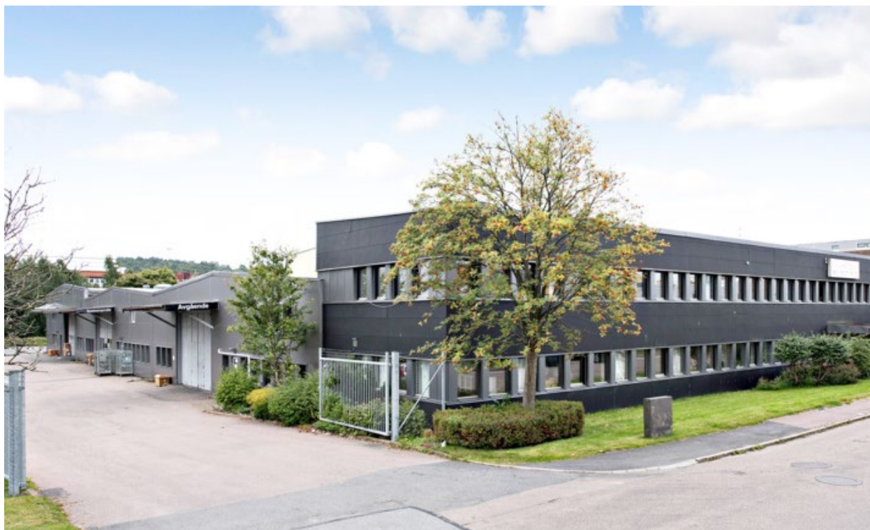
Högsbo 38:3 , som med energideklaration klass A utgör en av Corems gröna tillgångar enligt Corems gröna ramverk.
