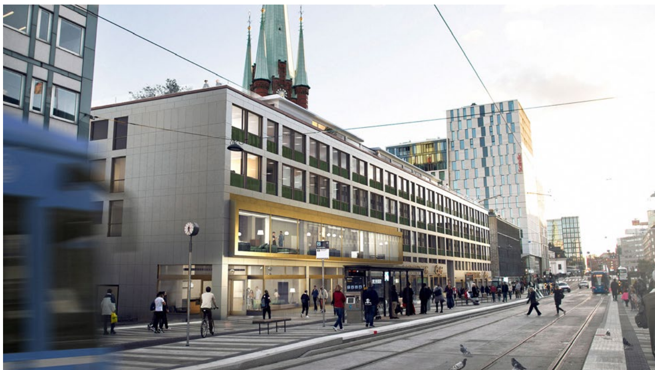
Fastigheten Orgelpipan 4 på Klarabergsgatan 33–35 i Stockholm håller på att färdigställas efter ombyggnation och modernisering. Fastigheten är fullt uthyrd, under fjärde kvartalet kommer Riksbanken och restaurangen AML att flytta in i lokalerna.
