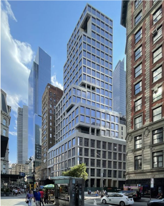
1245 Broadway, New York Corems största pågående projekt är en 23 våningar hög kontorsbyggnad längs med Broadway.
