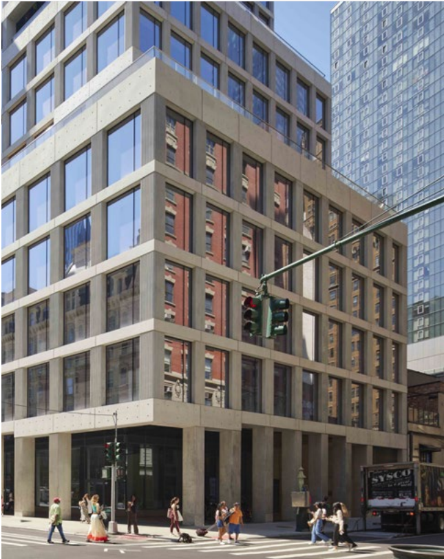
1245 Broadway, New York Corems största pågående projekt är en 23 våningar hög kontorsbyggnad på 1245 Broadway.
