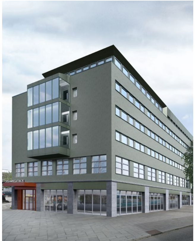
Helgafjäll 5, Stockholm I Kista, fastigheten Helgafjäll 5, pågår ombyggnation och hyresgäst-anpassning för Mycronic med planerad inflyttning tredje kvartalet 2025.
