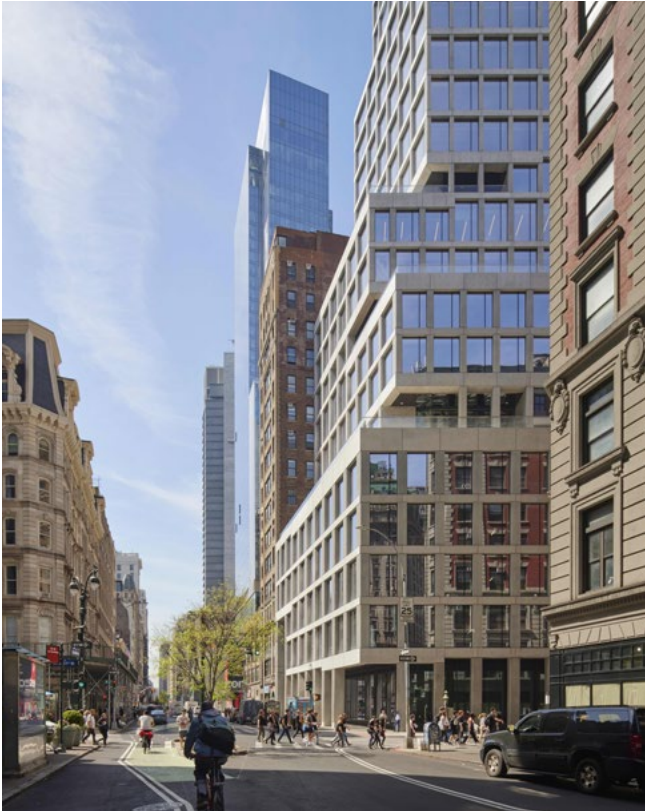
1245 Broadway, New York Corems största pågående projekt är en 23 våningar hög kontorsbyggnad på 1245 Broadway.
